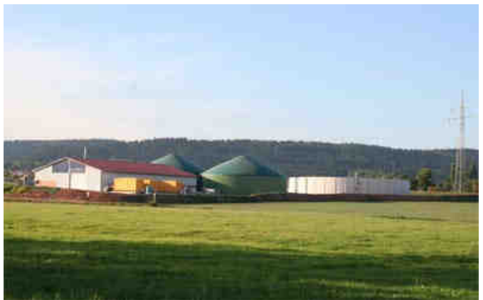
Biogazownia „SBW Biogas Lelbach“ (Korbach, Niemcy, 500 kW el )
