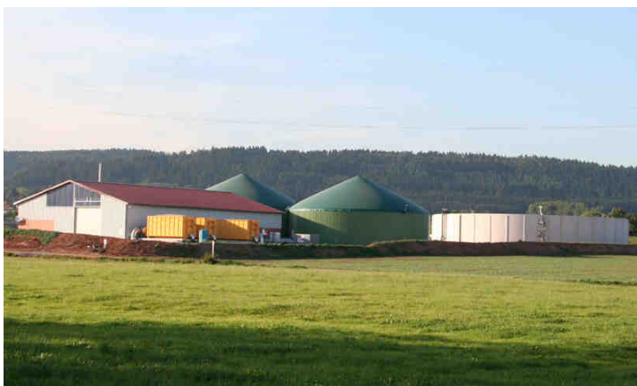
Biogazownia Lelbach (Niemcy) wybudowana przez firmę EnerCess GmbH
